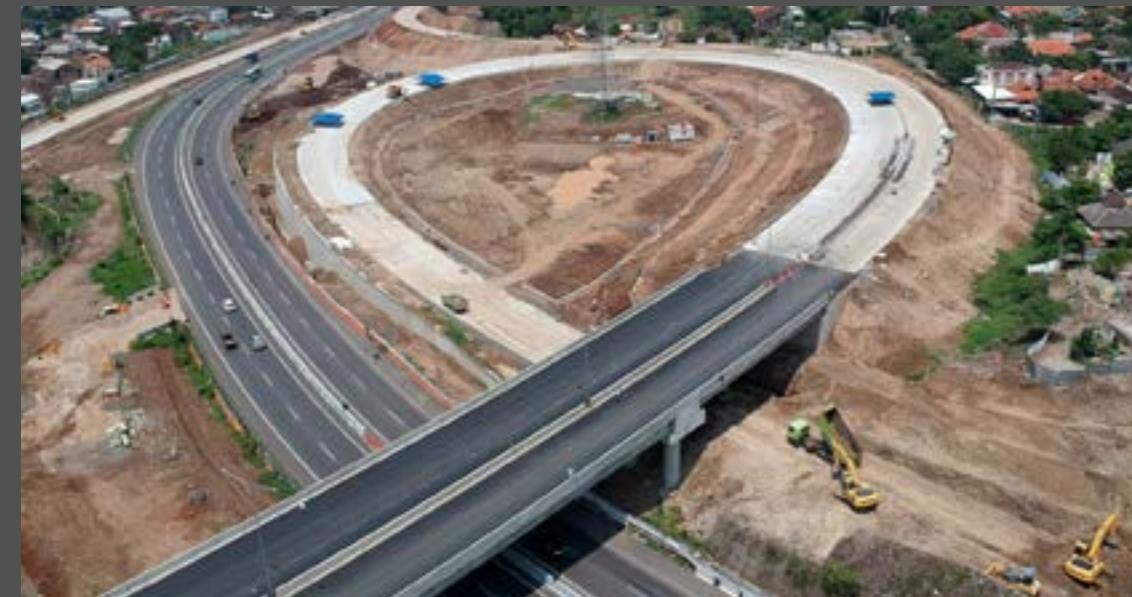
Foto udara pembangunan Simpang Susun Krapyak di titik pertemuan proyek Tol Semarang-Batang dan Tol Dalam Kota Semarang, Jawa Tengah (Foto: ANTARA FOTO/ Aditya Pradana)
