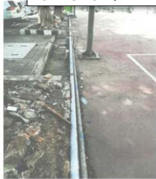
PERBAIKAN PIPA SUPPLY AIR BERSIH GEDUNG A, B DAN D (KANTOR PUSAT)
