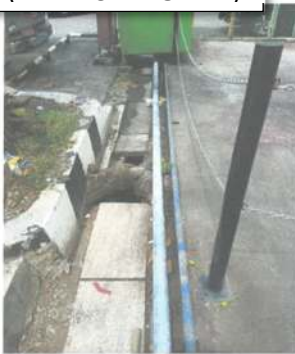
PERBAIKAN PIPA SUPPLY AIR BERSIH GEDUNG A, B DAN D (KANTOR PUSAT)
