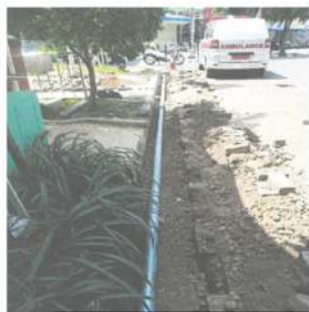
PERBAIKAN PIPA SUPPLY AIR BERSIH GEDUNG A, B DAN D (KANTOR PUSAT)
