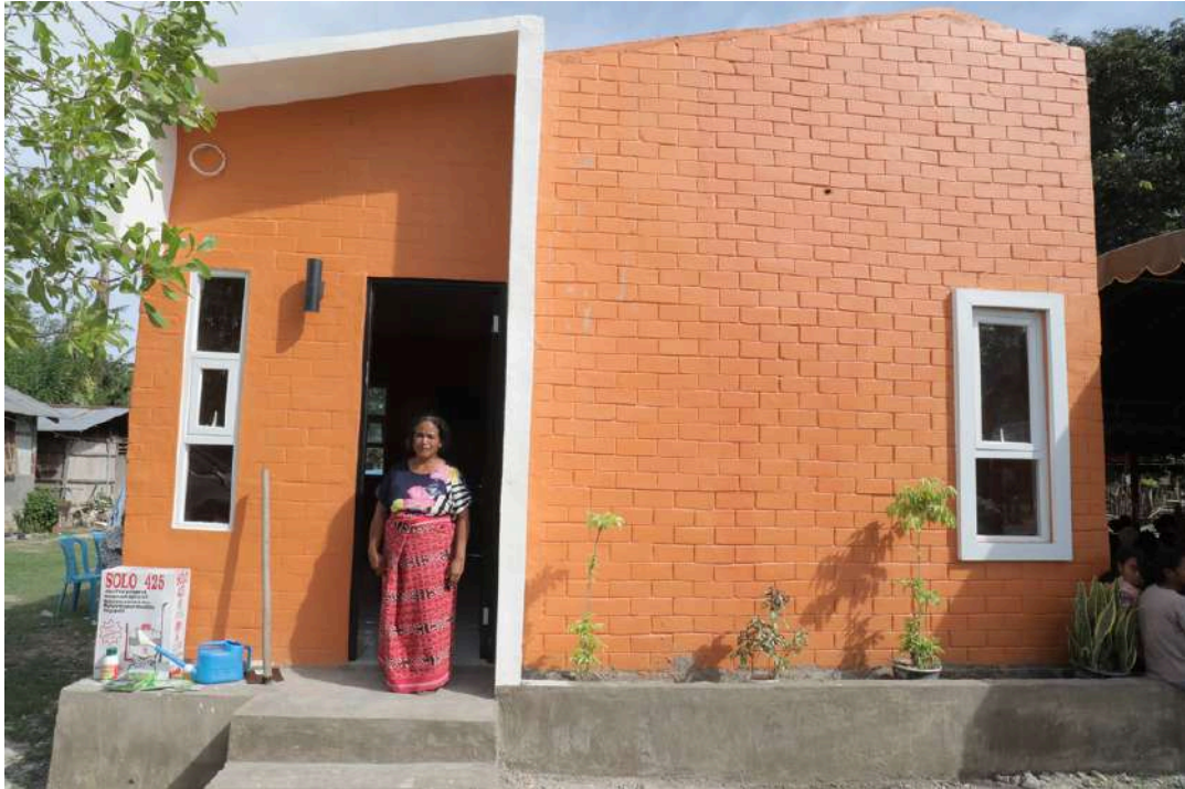
Gambar 3.28 Rumah tahan gempa bagi warga di Jalan Betun-Perbatasan, Desa Alas Selatan, Kecamatan Kobalima Timur, Kabupaten Malaka, Nusa Tenggara Timur. Rumah tersebut dibangun dengan bata interlock yang memiliki ketahanan tinggi terhadap gempa, berukuran 6 meter x 6 meter dengan 2 kamar tidur, 1 kamar mandi, dan dapur.
